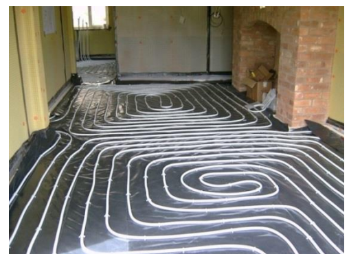
RISCALDAMENTO A PAVIMENTO
